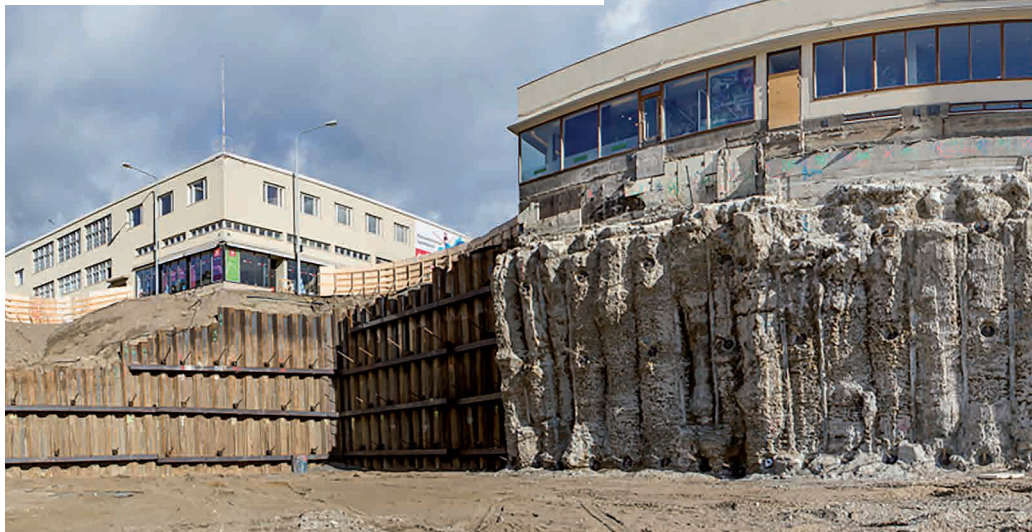
(Vasemmalla) Suihkuinjektoituja koepilareita, (alla) paluuvirtauslietteen erotin ja linja-autoaseman valmista suihkuinjektointiseinää.
