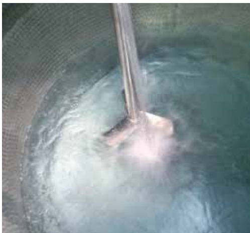
Kuvat vasemmalla ja keskellä: Betonin lisäaineet on suositeltavaa sekoittaa mekaanisesti esimerkiksi lapasekoittimella.
