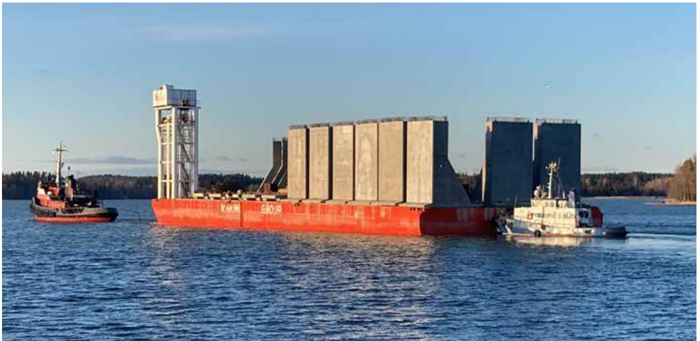
Isot laituri- elementit kuljetettiin Maarianhaminasta proomulla Paraisille.
