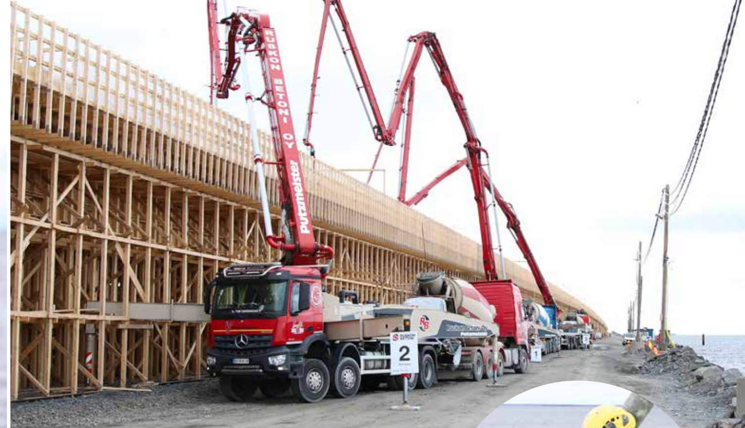
Logistiikka toimii. Betoniautot ovat päässeet suoraan pumppauspaikalle ja jatkaneet matkaa sillan kiertämällä, ei paikallaan ympäri venkslaamalla. Näin valutyöt etenivät telaketjumaisesti eteenpäin.
