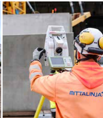
14 metrin pilari painaa 22 tonnia. Huuhka Oy:n miehet asentavat sen paikoilleen mittamiehen millintarkkojen ohjeiden mukaan.
