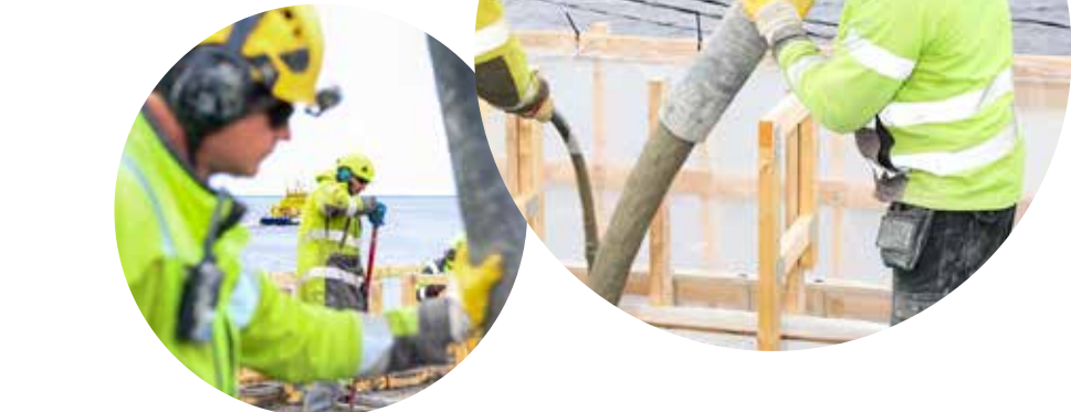
Logistiikka toimii. Betoniautot ovat päässeet suoraan pumppauspaikalle ja jatkaneet matkaa sillan kiertämällä, ei paikallaan ympäri venkslaamalla. Näin valutyöt etenivät telaketjumaisesti eteenpäin.
