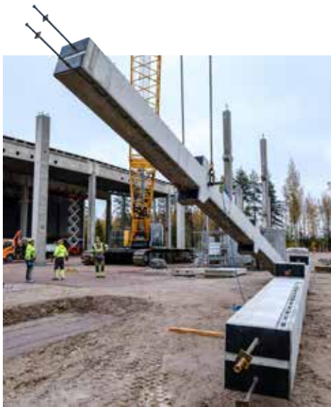
14 metrin pilari painaa 22 tonnia. Huuhka Oy:n miehet asentavat sen paikoilleen mittamiehen millintarkkojen ohjeiden mukaan.
