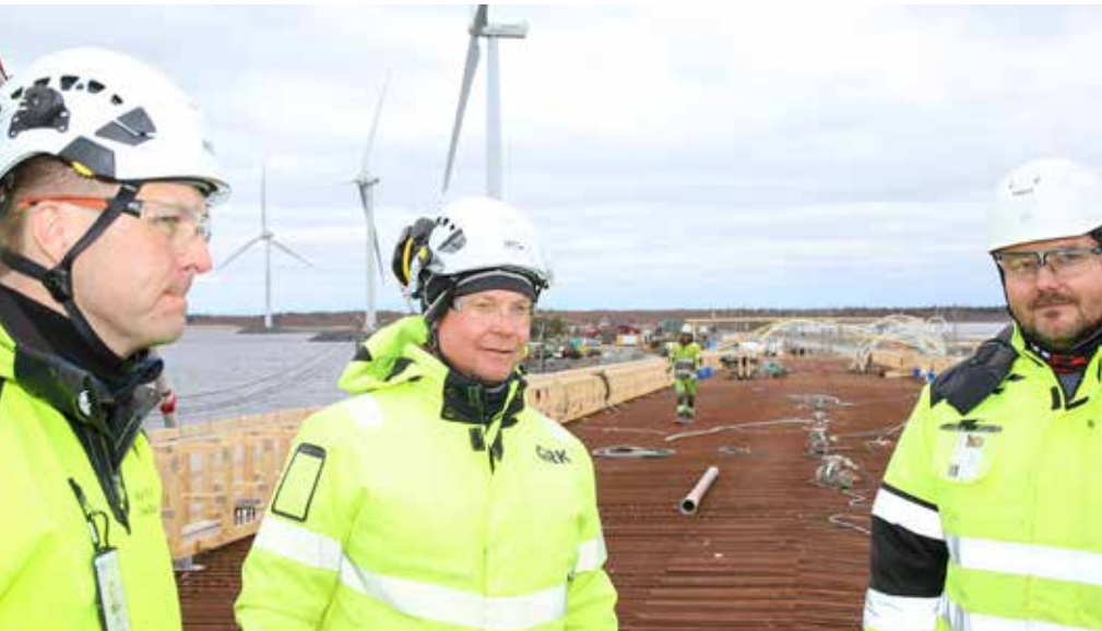
Väyläviraston projektipäällikkö Jukka Päckilä (vas.), GRK:n tuotantopäällikkö Jouni Karvonen ja rakentaja-allianssin projektipäällikkö Timo Takala, GRK, huokaisevat helpotuksesta, sillä projekti on sujunut suunnitelmien mukaan.
