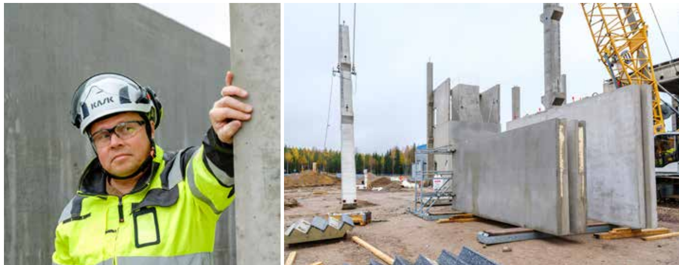
– Tuoreen vähähiilisen betonin pinta voi olla sävyiltään tummanvihertävä, mutta tasoittuu kuivuessaan. Väri tulee erilaisista sideaineista, Jari Issakainen kertoo.
