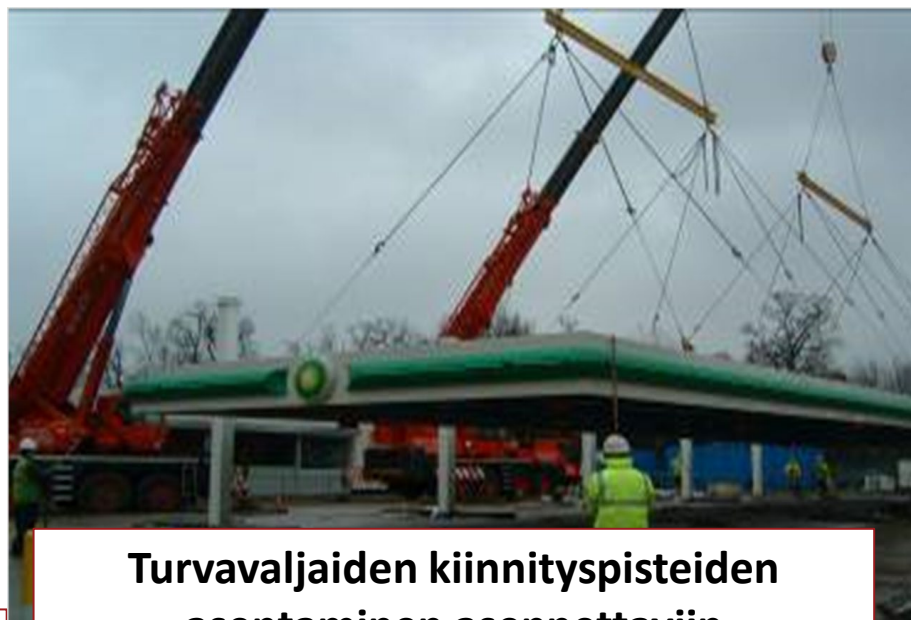
Maatasolla kasaaminen – nostaminen paikoilleen
