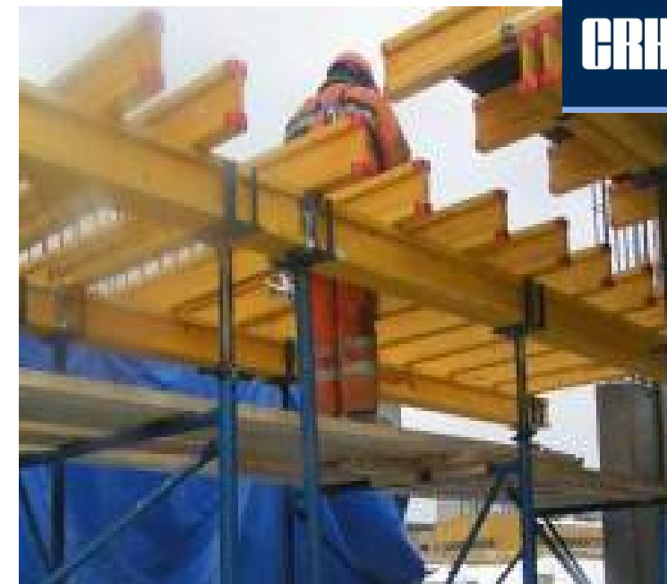
Muottien kasaaminen alapuolelta
