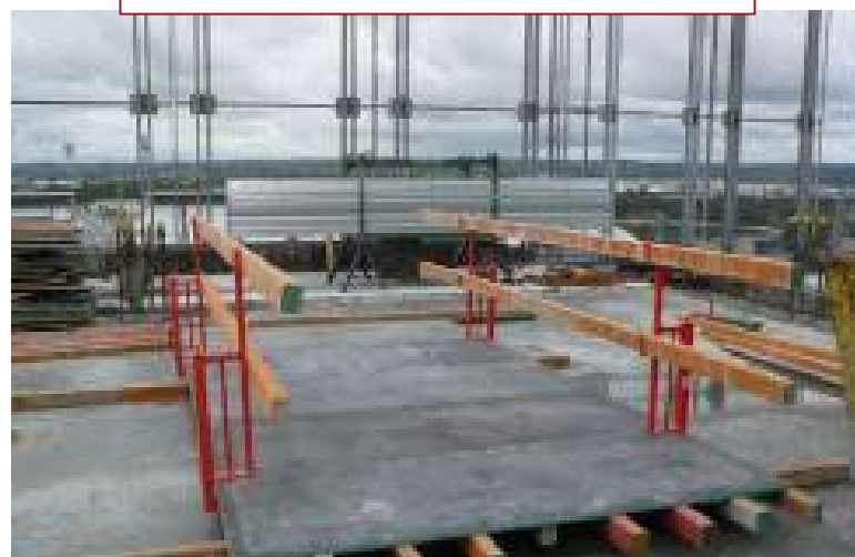
Katteet ja kaitteet asennettu maatasolla
