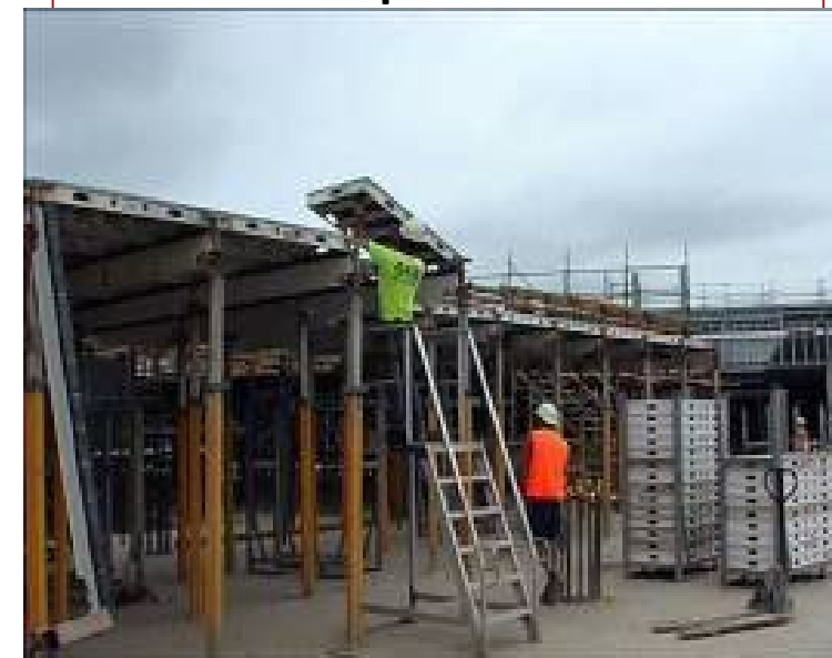
Muottien kasaaminen alapuolelta
